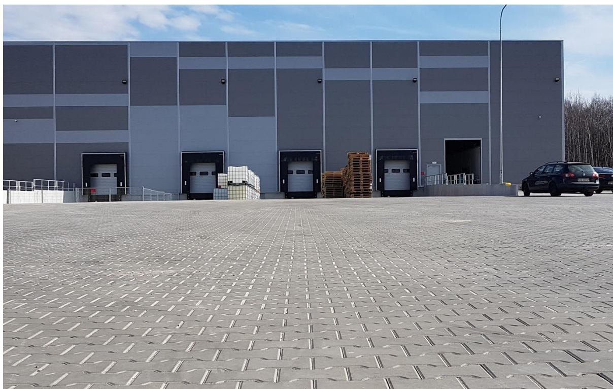
Fot: Śląskie Centrum Logistyczne, nowa hala nr 5
